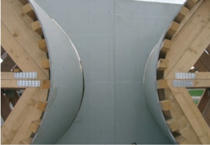
Abb. 3: Schalungsbau – Kunststoffplatten
