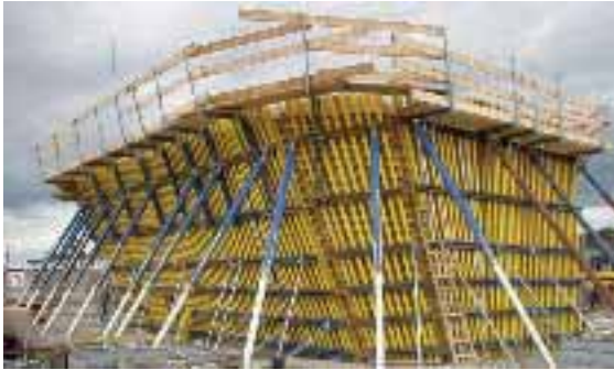
Phaeno Science Center, Wolfsburg, eingerichtete Schalung Fotos: © VÖZ Expertenforum/Arch. Peter M. Bährle
