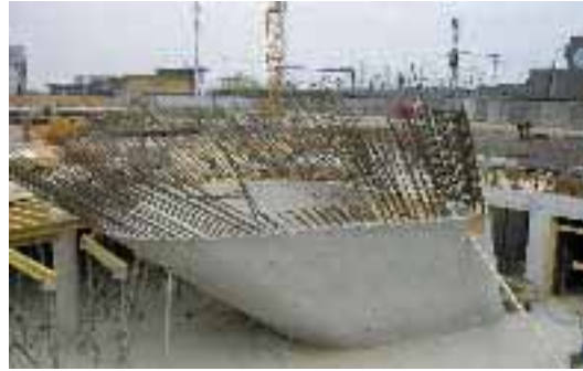
SCC-Lösung für Wände mit geneigten und gebogenen Wandquerschnitten, die ein Verdichten des Betons in der Schalung unmöglich machen
