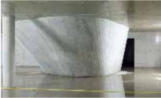
Phaeno Science Center, Wolfsburg, betonierter Baukörper; plastische Formgebung in einem Stück
