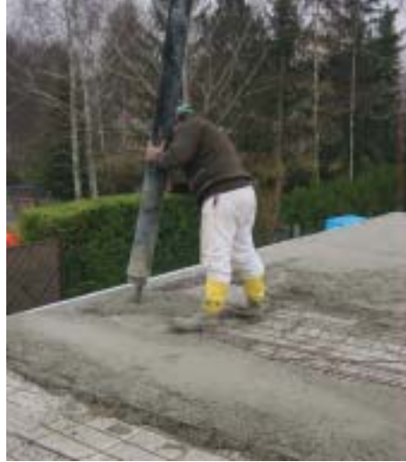
Bild 5: Versuch: Einsatz ohne Bremse, nur mit Endverteilerschlauch
