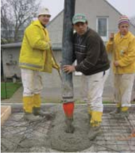
Bild 4: Versuch: Einsatz des Bremskonus ohne Schutzmantel
