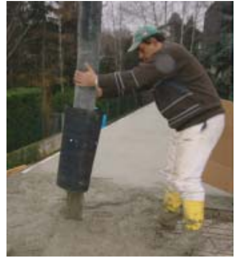
Bild 6: Prüfung mit verstellbarem Schutzschlauch
