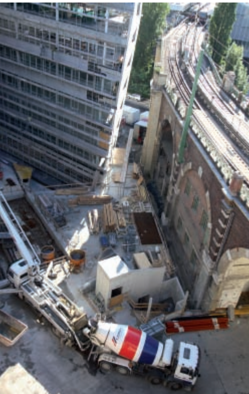
Extrem beengte Lieferbedingungen bei der Anlieferung des Transportbetons Foto: © Cemex
