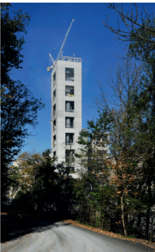
Das neue Wahrzeichen nach dem Anfahren der neuen Ofenlinie
