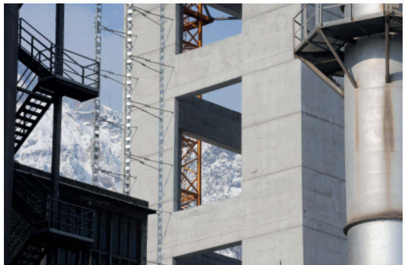
Die Hochbauarbeiten zum WT3 wurden im März 2010 fristgerecht abgeschlossen.
