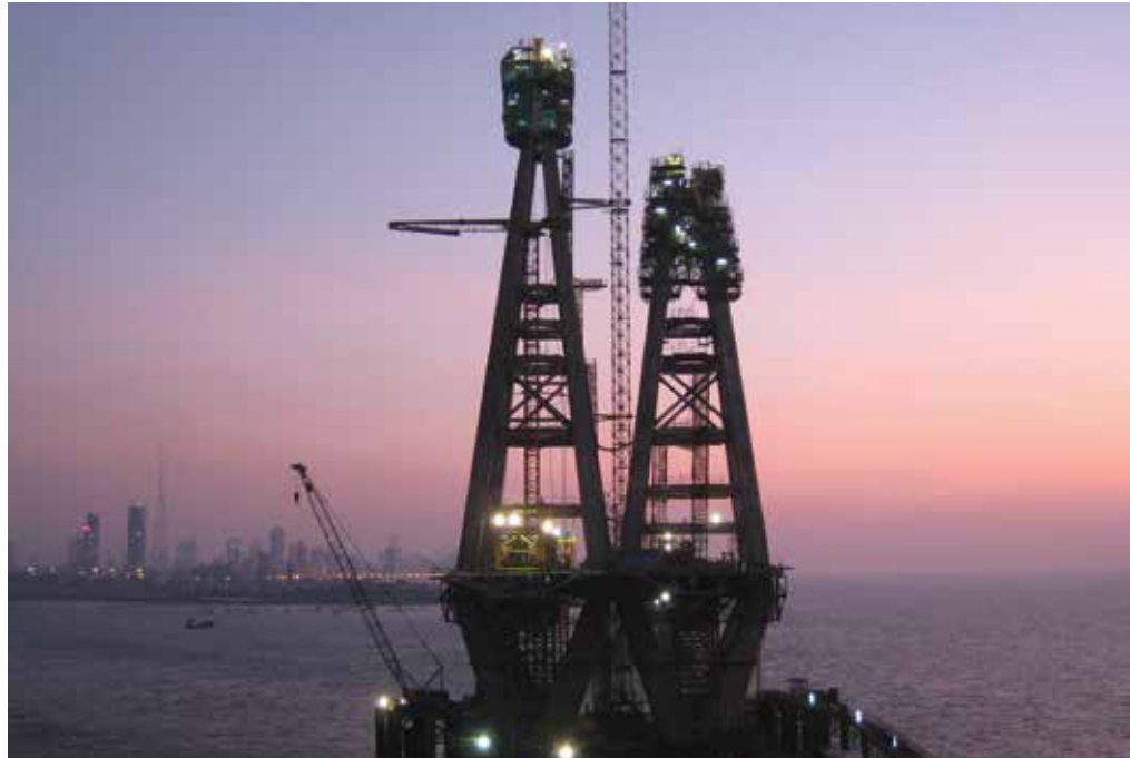
Mit Schalungs-Know-how von Doka konnten die hohen Sichtbetonanforderungen beim Bau der Meeresautobahnbrücke in Mumbai erfüllt werden.
