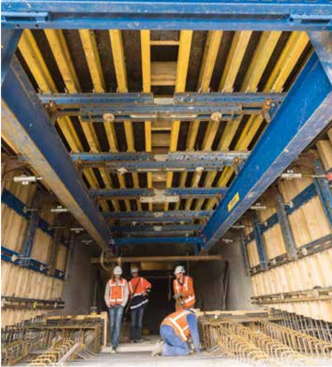
Bau der Brücke über den Amsterdam-Rhein-Kanal
