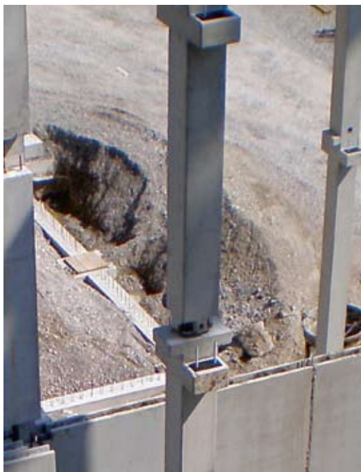
300 Stück der 21 Meter hohen Betonfertigstützen wurden mittels Peikko®-PEC-Stützenschuhanschluss versetzt.
