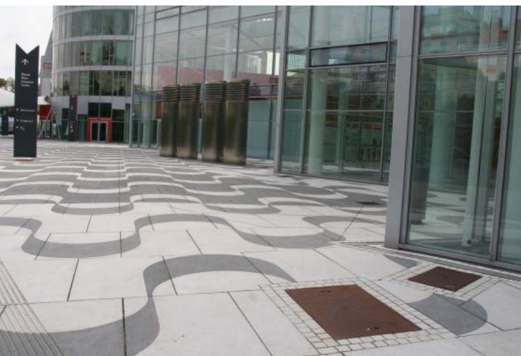
Abb. 10: Außenanlage Wiener Messe (2003)
