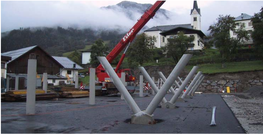
Stützen aus SCC
