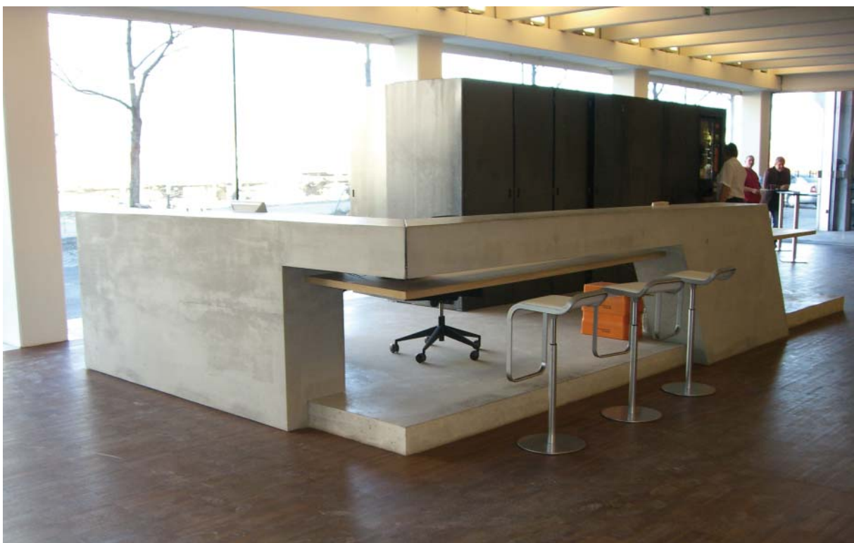
Bar – Sichtseiten schalglatt
