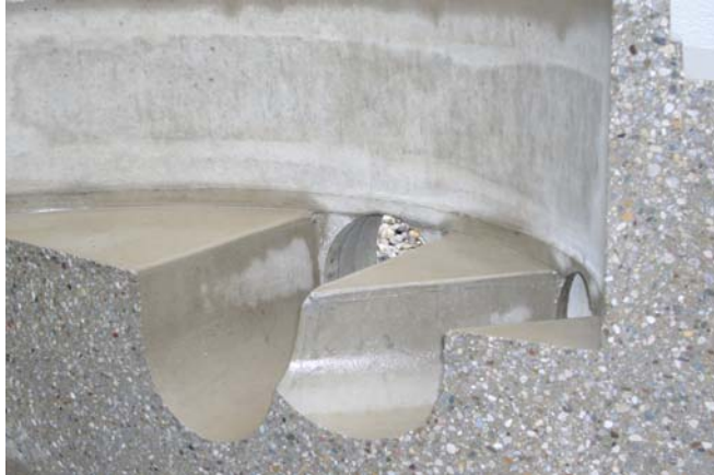
Bild 3: Monolithischer Aufbau des Betonkammerbodens – aus einem Guss
