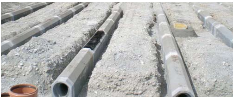
Abb. 1: 1. Schritt | Einbau in den Frostkoffer (Baustelle SAB – Salzburg)
