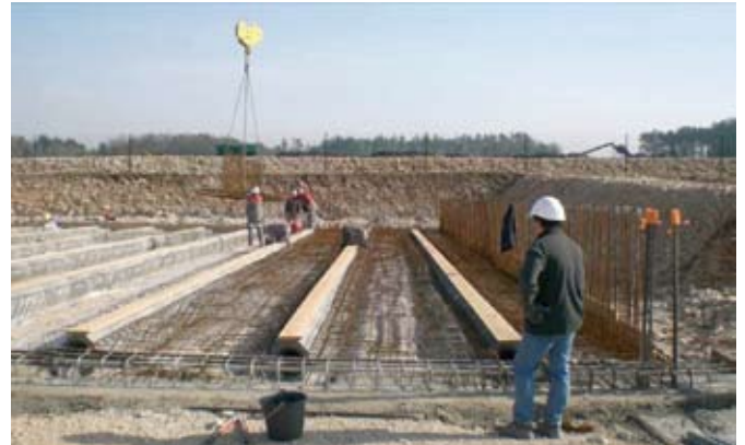
Abb. 4: Einbau in die Rottefläche (Baustelle Chaumont – Frankreich)
