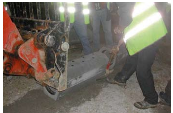
Abb. 5: Verlegung der Betonbelüftungsrohre in Portugal – Baustelle Setubal, Lissabon
