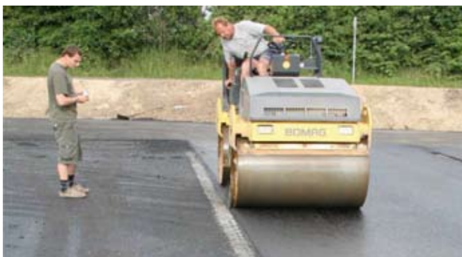
Abb. 2: 2. Schritt | Asphaltierung – die Belüftungsrohre liegen direkt unter der Rottefläche (Baustelle Seiringer – NÖ)
