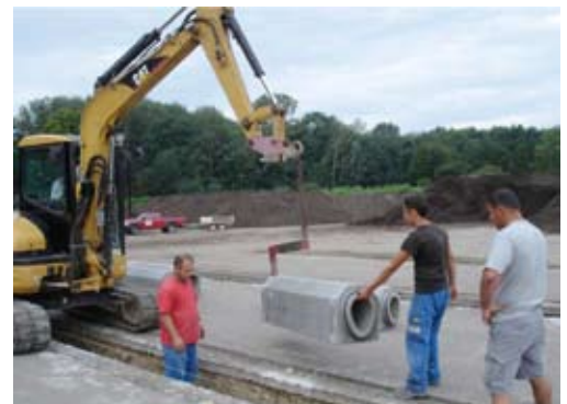
Abb. 3: Einfache und schnelle Rohrverlegung mit Muffen/Stutzen-System (Baustelle AVT Traismauer – Traismauer)
