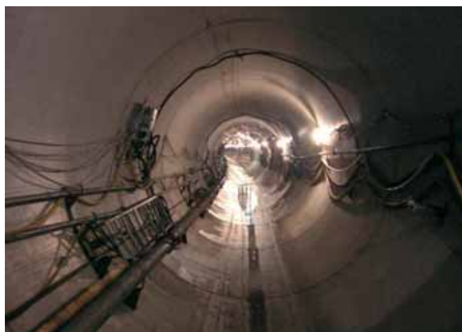
Blick in den vorgepressten Rohrstrang
