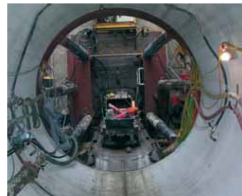
Blick in den vorgepressten Rohrstrang
