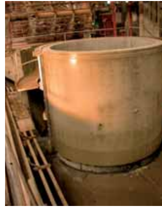
MABA – Fertigung der Vorpresse
