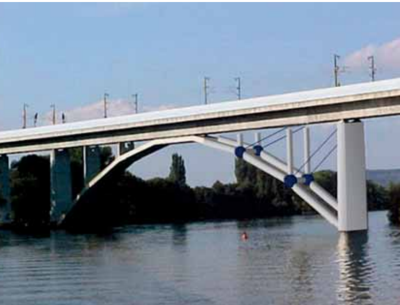
Abb. 1: Bogenbrücke mit Schleuderbetonstäben
