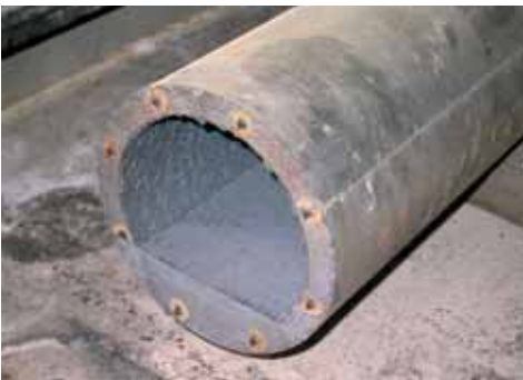
Abb. 4: D-Stab mit CFK-Drähten vorgespannt
