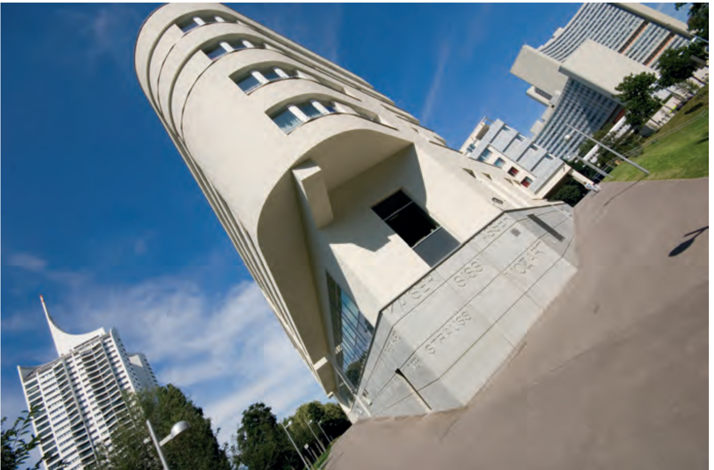
Fassadenplatten ARCOTEL Kaiserwasser
