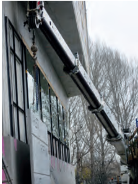
Die engen Platzverhältnisse forderten höchste Konzentration.
