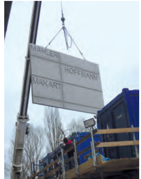
Kran beim Versetzen eines Fassadenelementes
