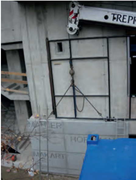
Montage der Elemente an Unterkonstruktion
