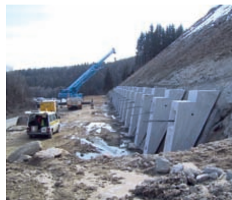
Bild 3: Nach dem Bohren der Anker – Montage der Fertigteile
