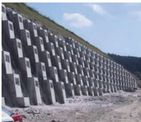
Bild 4: Fertige Wand, noch ohne Pflanzentröge
