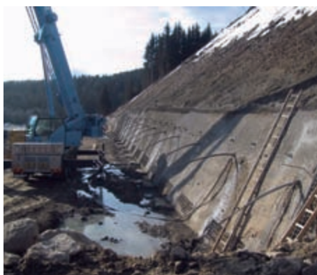
Bild 2: Hangabtrag, Aufbringen der Spritzbetonschale, Beginn der Montagearbeiten
