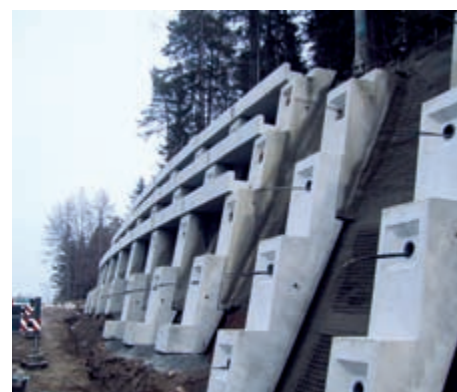
Bild 5: Oberer Hangbereich bereits fertig, weitere Etagen noch im Bau
