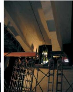
Ein drittes Beispiel für die Anwendung von Fertigteilen im Brückenbau ist die Errichtung von zwei Überführungen über die Autobahn auf der Pack. Hier wurden Fertigteilelemente für die Errichtung des Tragwerkes in Verbundbauweise auf einem Stahltragwerk verlegt. Der Randbalken wurde ebenfalls in Fertigteilbauweise errichtet. Das gesamte Betontragwerk wurde in Hochleistungsbeton C 45/50 ohne Isolierung und Belag ausgeführt.
