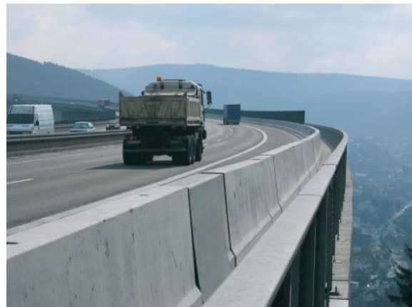
H4b-Absicherung der Siegtalbrücke – A45 Deutschland
