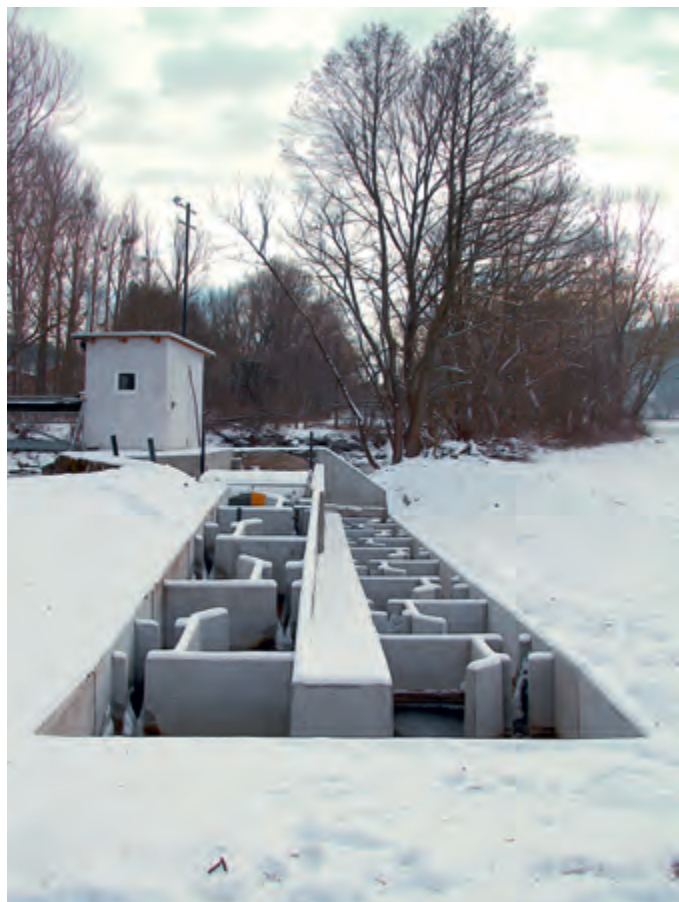
Die Fertigteile werden von MABA FTI auf einer Splittauflage rasch versetzt.
