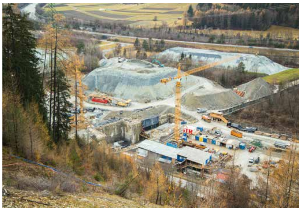
Krafthausbaustelle in Prutz
