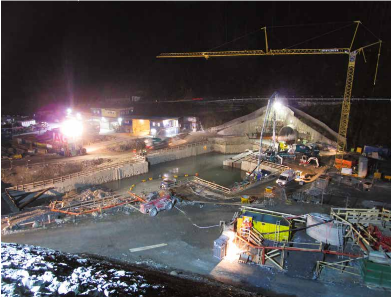
Einbau Unterwasserbeton
