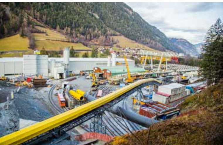
Baustelle in Maria Stein im Dezember 2015, Ausgangspunkt für den Stollenvortrieb
