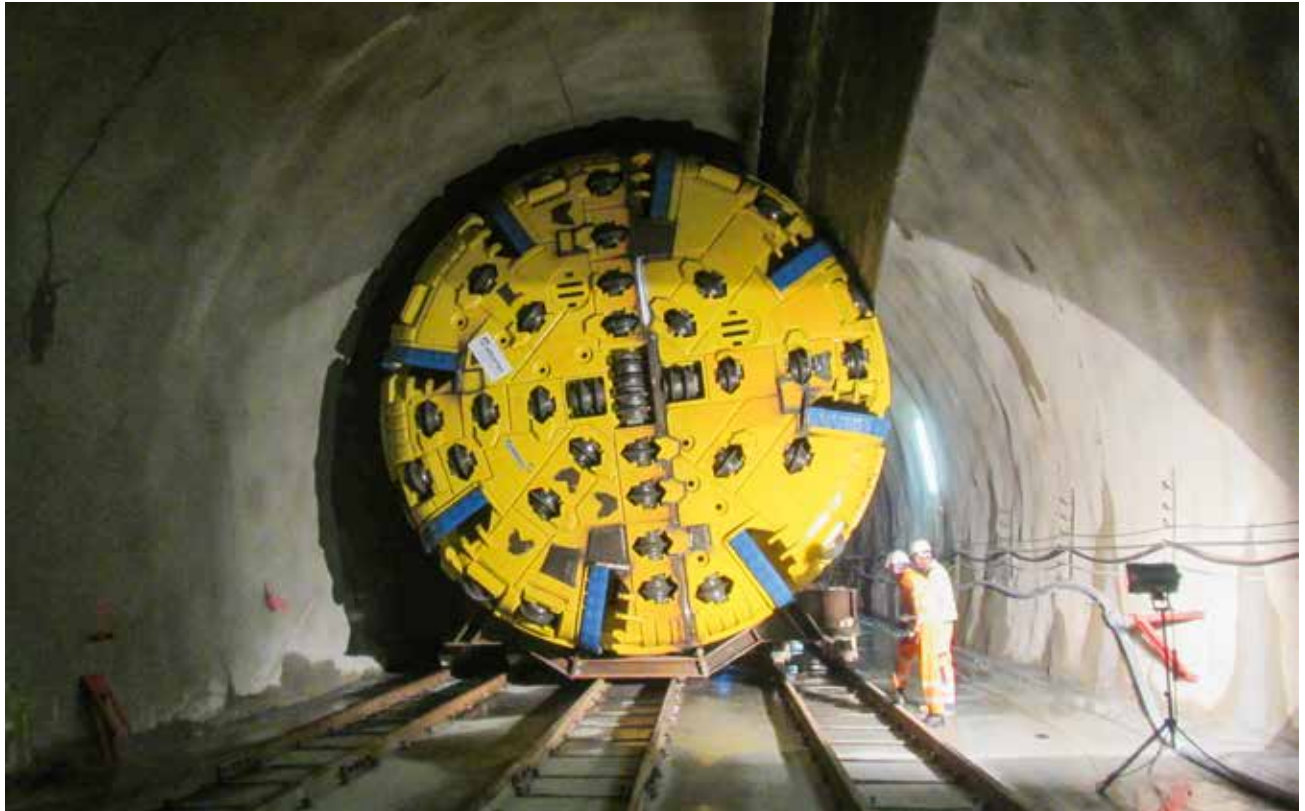
Die Tunnelvortriebsmaschine im Stollen
