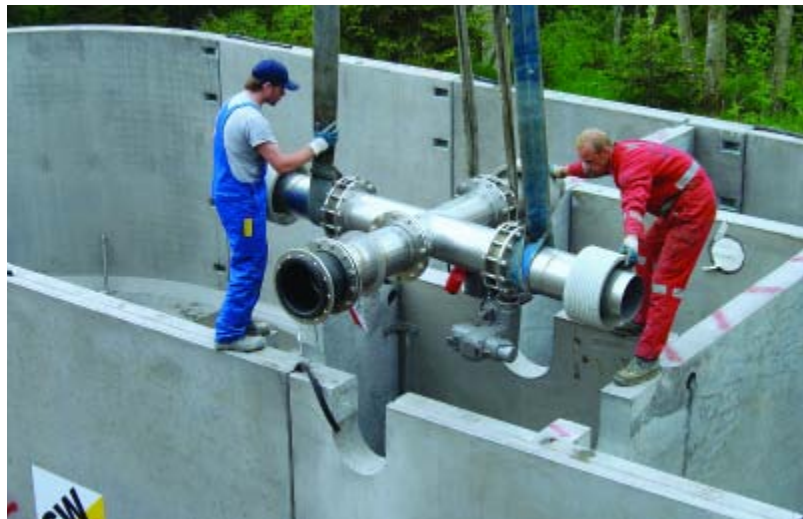
Einbau von fernwirkgesteuerten Armaturen in die Schieberkammer einer Gewässerschutzanlage
