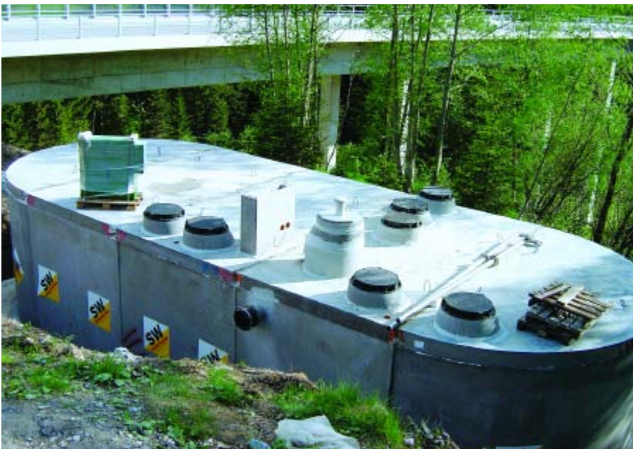
Gewässerschutzanlage fertig montiert
