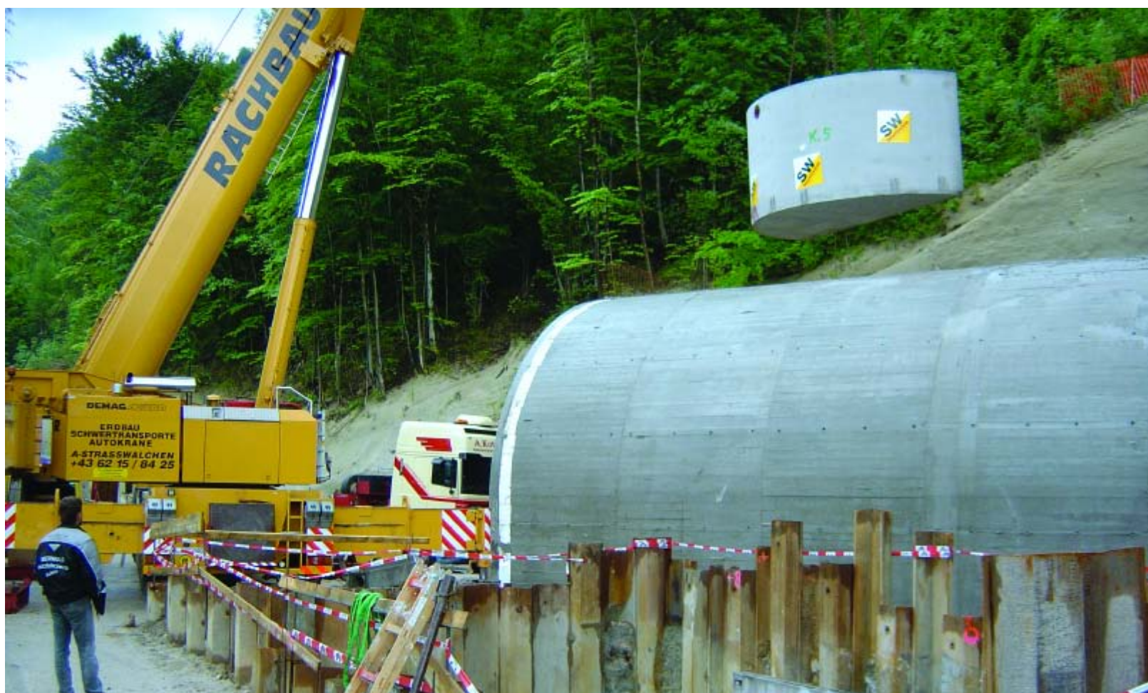
Bauvorhaben Gewässerschutzanlage Mitterbergtunnel
