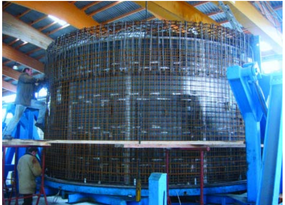
Bewehrungsarbeiten am Kern der Stahlform eines Halbschalenelementes
