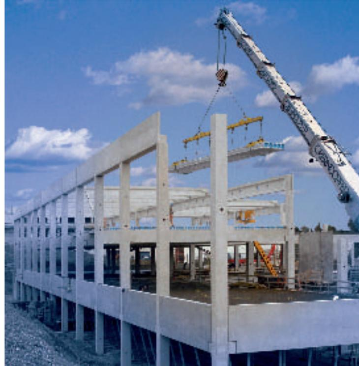
In einer Rekordmontagezeit von nur 12 Wochen wurden 850 LKW-Transporte mit 21.800 Tonnen Fertigteilenelementen der Firma Franz Oberndorfer GmbH & Co. verbaut. In mehreren Bauabschnitten wurden schrittweise von 3 Montagepartien mit insgesamt 10 Mitarbeitern – unterstützt von 2 Stück 160-Tonnen-Autokränen – Köcher, Stützen, Unterzüge und Deckenplatten sowie TT-Elemente als Zwischendecken versetzt, bevor zum Ende eines Bauabschnittes die Dachkonstruktion mit Bindern und Pfetten verlegt wurde.
