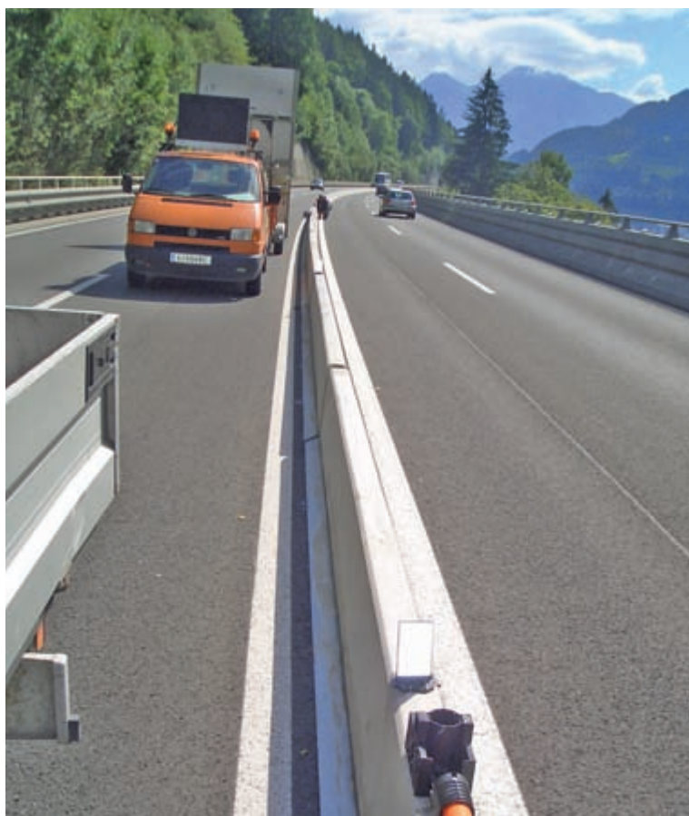
DB 50S Mittelabsicherung, Bischofshofen
