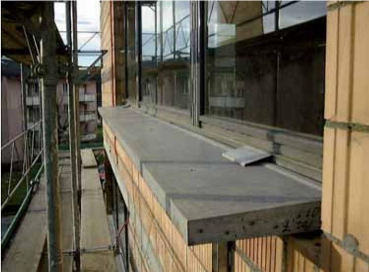
Abb. 5: Carbolith®-Fensterbank der Länge 4,7 m
