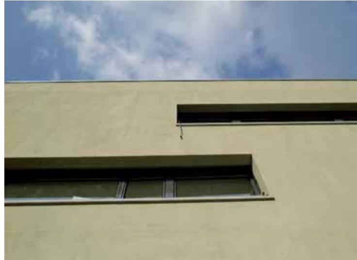
Abb. 6: Fassade mit filigranen Carbolith®-Fensterbänken
