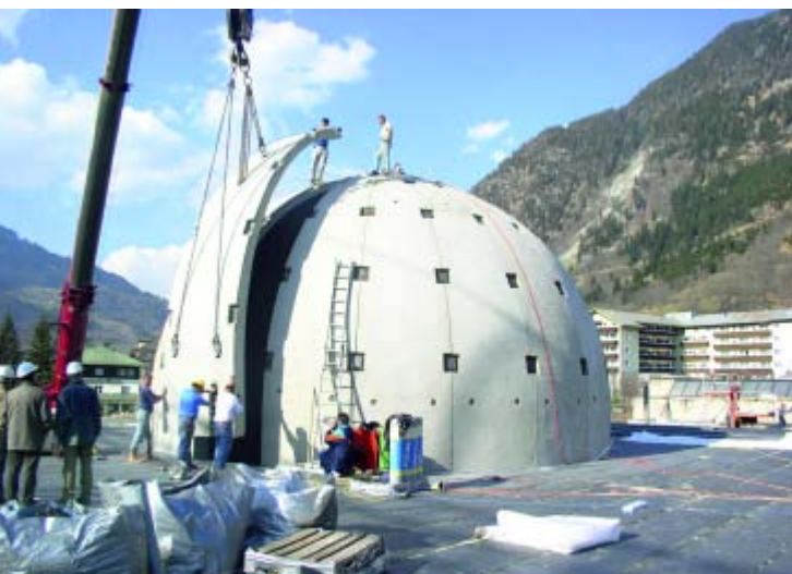
Abb. 2: Einheben des letzten Segments
