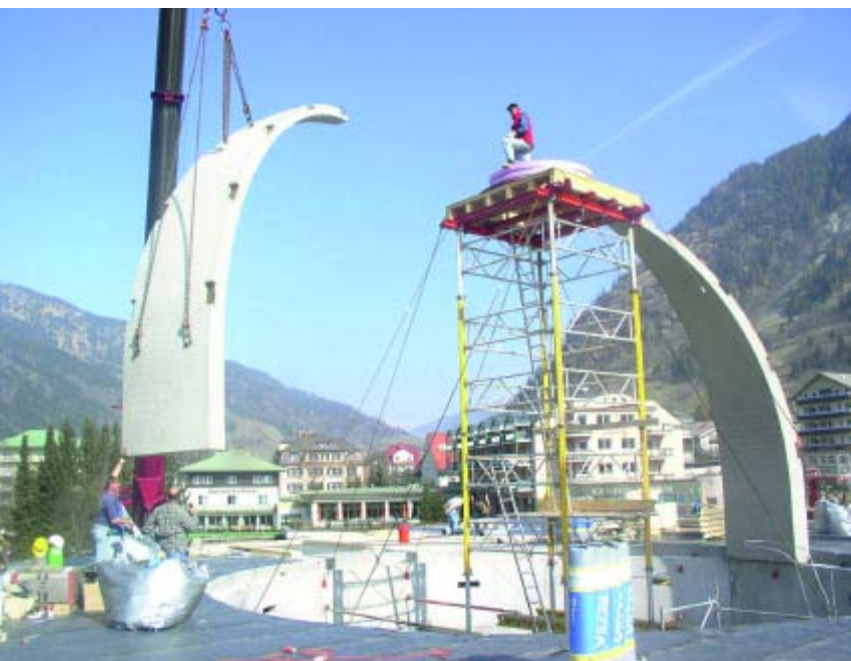
Abb. 7: Die ersten Teile werden versetzt
