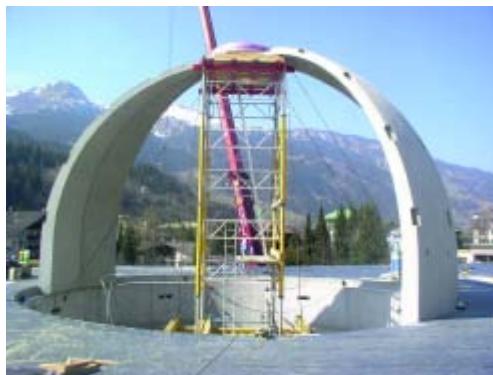
Abb. 5: Wechselseitige Montage der Einzelteile
