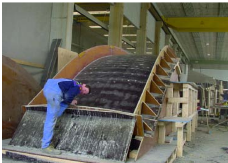
Abb. 3: Der Schalungsbau im Werk
