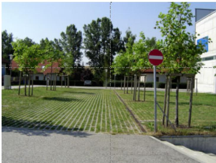
Die praktische Umsetzung der vorgenannten Vorschriften und Richtlinien ist die Versickerung der Oberflächenwässer über die belebte Bodenzone (Bodenpassage). Im Gegensatz zu den bisher üblichen technischen Lösungen (Flächenversickerung, Muldenversickerung) vereint der patentrechtlich geschützte GMS-Stein im Vertrieb der Ebenseer Betonwerke nun alle Anforderungen (gesetzliche und wirtschaftliche) in einem
