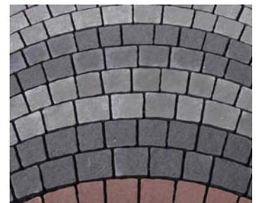
verschiedene Betonsteinblöcke zu einem Bogen zusammengesetzt. Das Verbindungsstück zwischen zwei Bögen ist der sogenannte Winkelstein. Der Winkelstein ist ein Betonsteinblock mit einer Scheinfuge, der den genauen Bogenwinkel aufgrund seiner Geometrie schon vorgibt. Als Alternative kann auf den Winkelstein auch verzichtet werden und die Bogensätze durch eine Änderung der Verlegerichtung wellenförmig verlegt werden. Die Symmetrie über die ganze Fläche ist immer gewährleistet.
