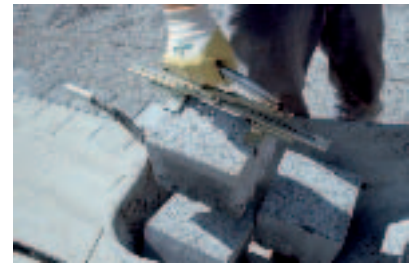
Bild 2: Verstellbare Verlegerzange zum leichten Versetzen kleinerer Steingrößen
