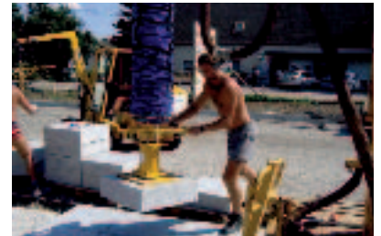
Bild 3: Verlegung mit Vakuumgerät
