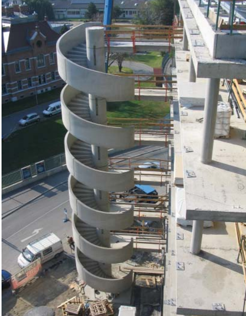
Ortbetonanbindung über sechs Geschosse
