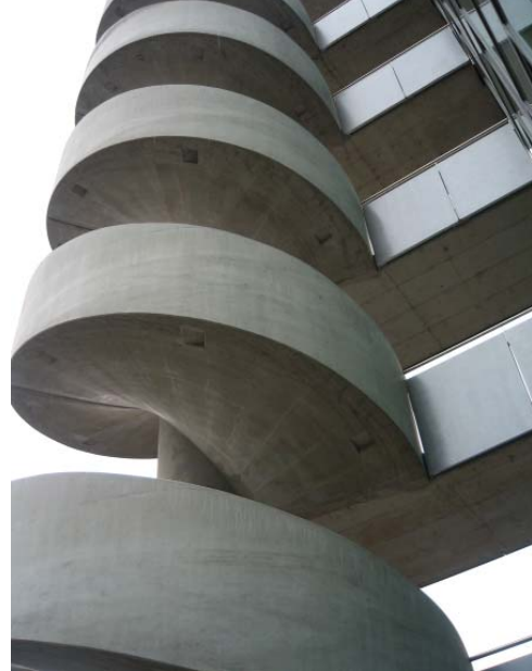
Unteransicht nach Fertigstellung
