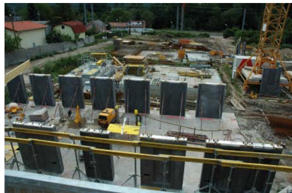
Fertigteile mit ISO-Körben
