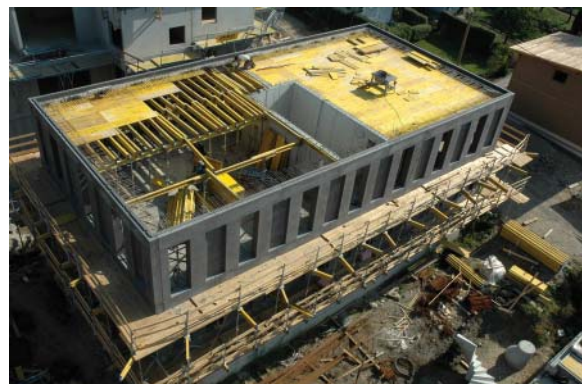
Vor der letzten Geschossdecke
