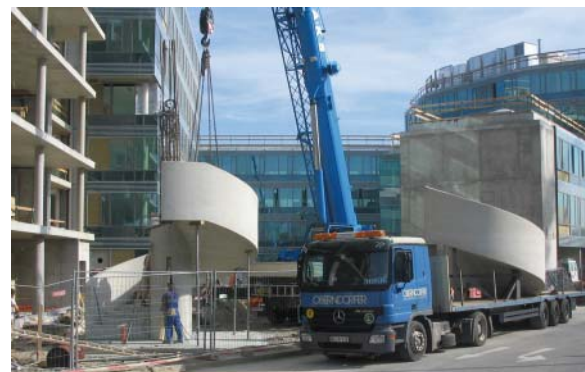
Anlieferung und Montage der Fertigteile
