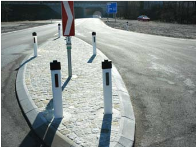
Leitpflock-Fundamentsteine geben sicheren Halt. Beschädigte Leitpflocke können jederzeit einfach getauscht werden
