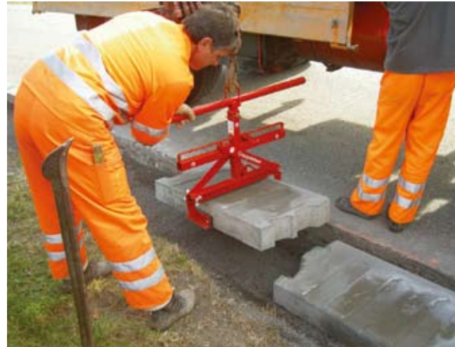
Einfaches und schnelles Verlegen mit der BG-Versetzzange
