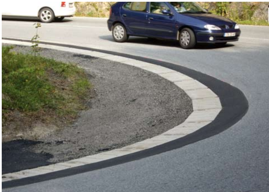
Bankettsanierung im Bereich von Innenkurven
