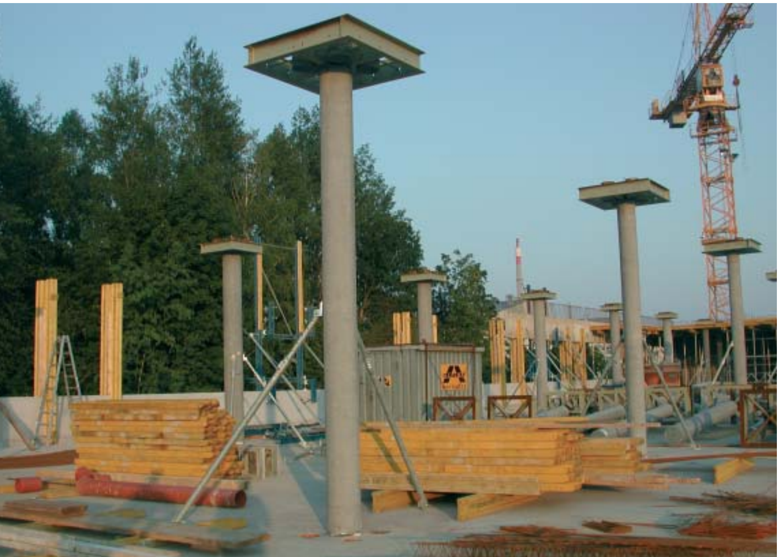
Abbildung 4: Einsatz von hochbewehrten Schleuderbetonstützen beim Bauvorhaben UKH Linz.
