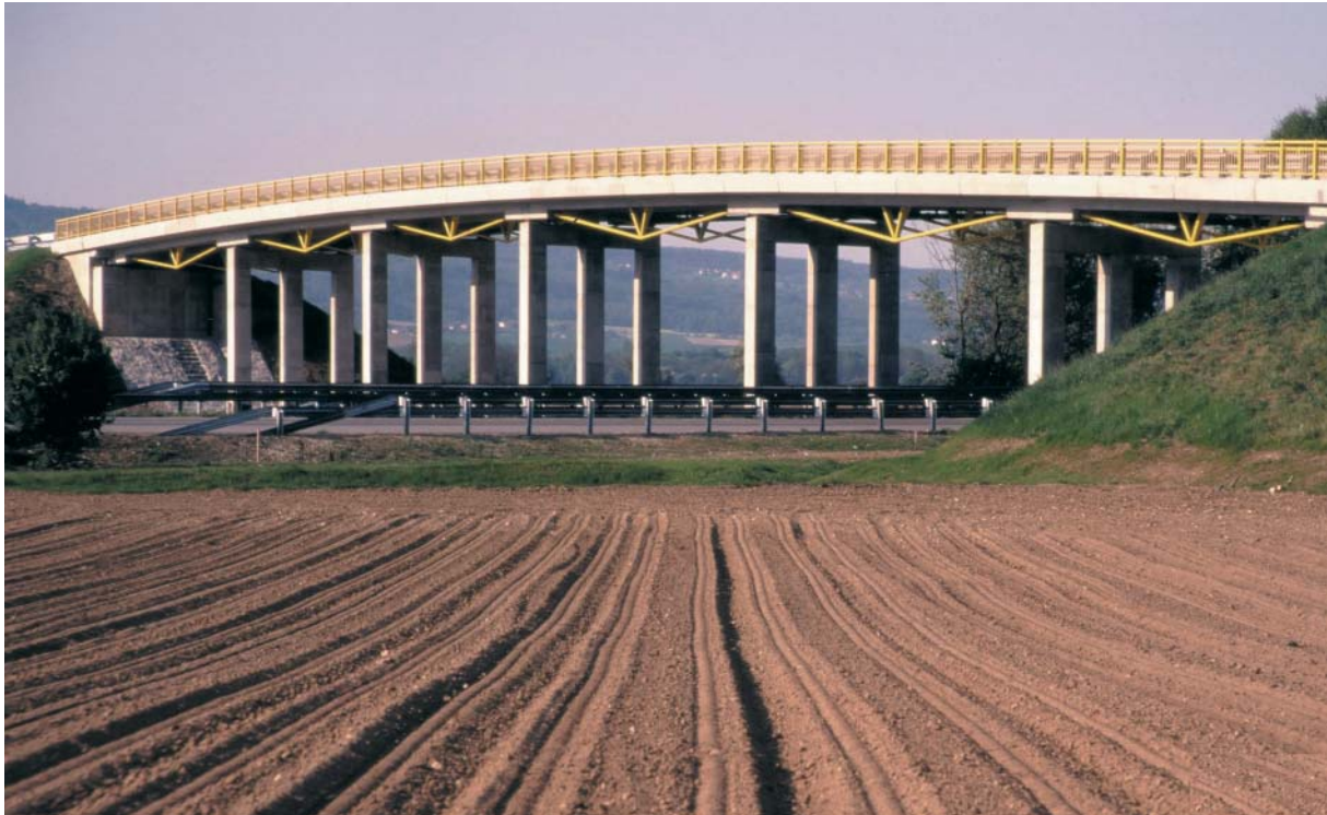
Bild 4: Brückenfamilie St. Pölten
