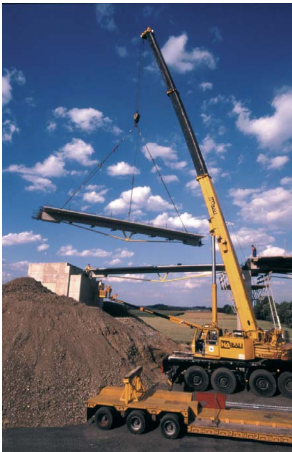
Bild 3: Brückenfamilie St. Pölten
