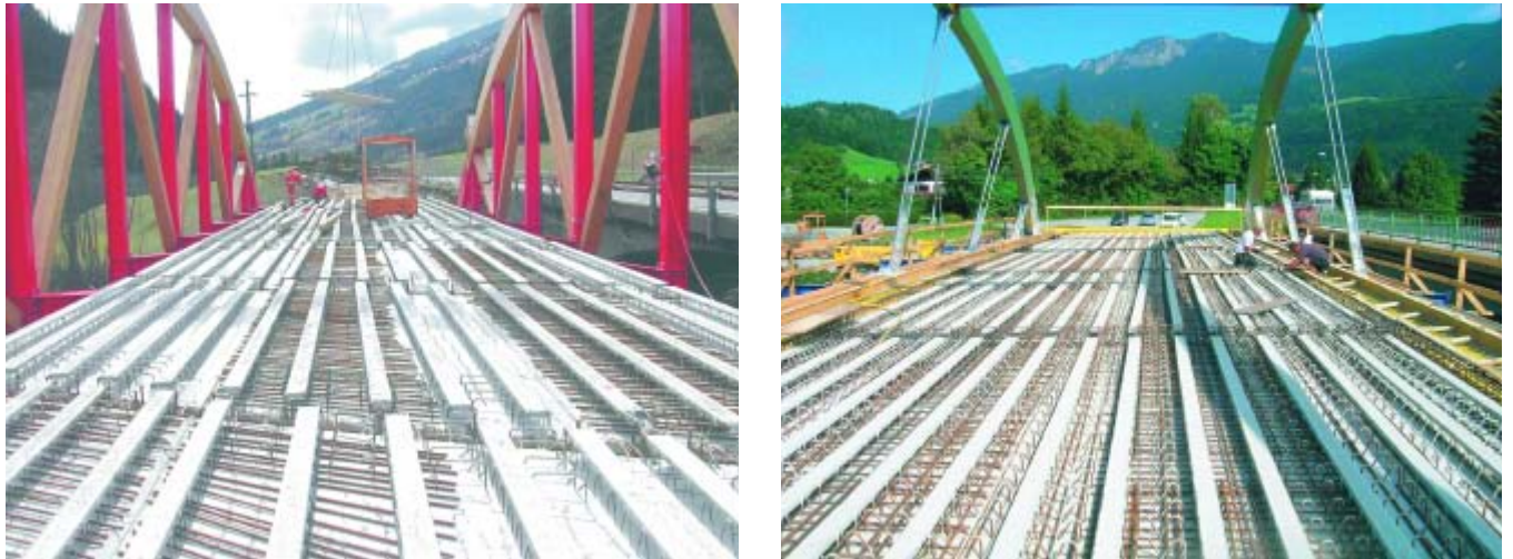
Abb. 8: Verlegezustand der Brücken Stranch und Mauthen
