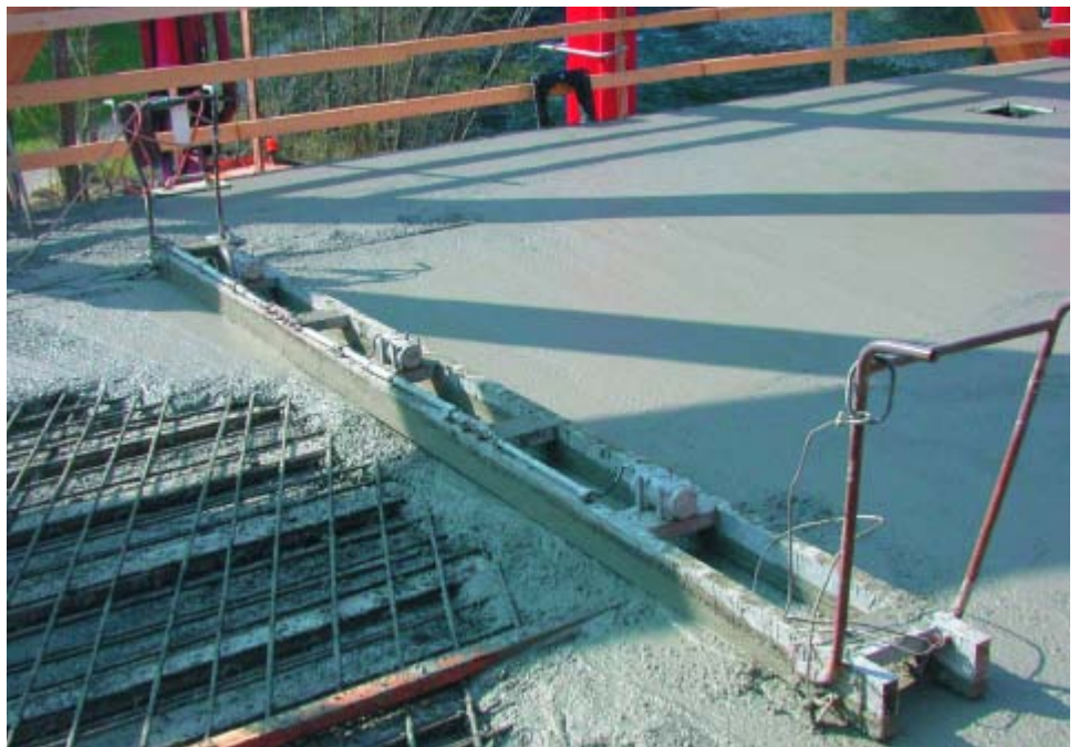
Abb.10: Betoniervorgang beim 2. Betonierabschnitt
