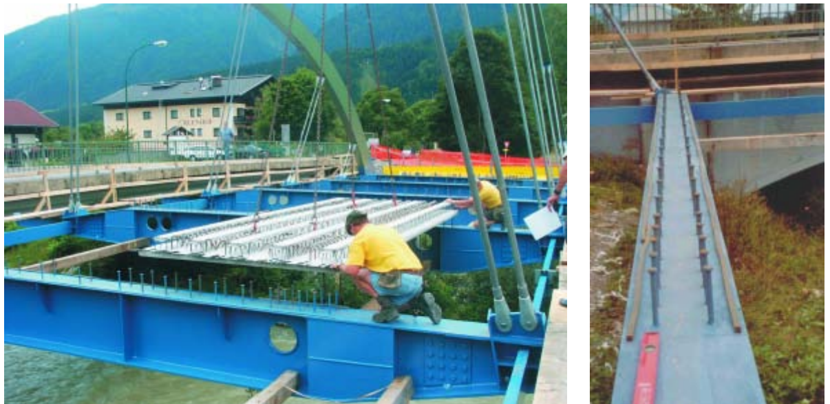
Abb. 5: Verlegen der Fertigteile auf den Stahlquerträgern
