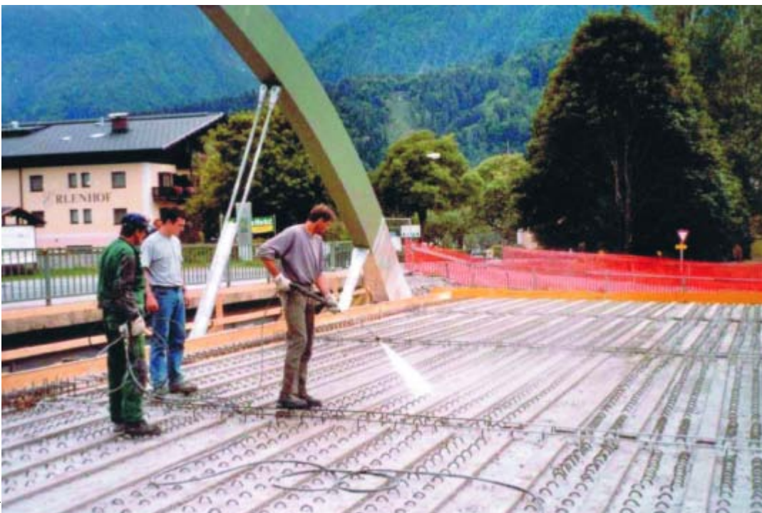
Abb. 9: Fahrbahnplatte vor Betonieren des 2. Betonierabschnittes
