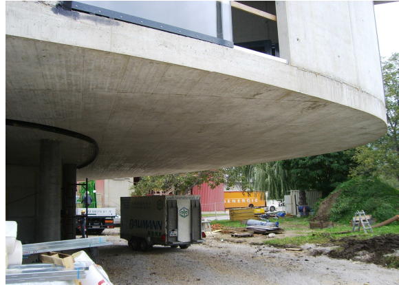
Neubau Bürohaus der Kirchdorfer Zementwerke, Deckenstärke 40cm, Auskragungen in Teilbereichen bis zu 8,50m, schlaff bewehrt, Betonkernaktivierung in Decken eingebaut
