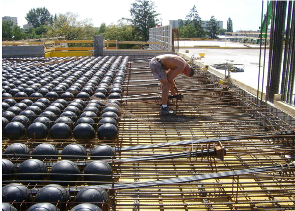
Messe Halle Graz, Foyerbereiche, Spannweiten zw. 10 und 20m, Deckenstärke 40cm, Kombination mit verbundloser Vorspannung in Teilbereichen
