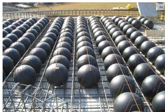
Teilfertiglösung – Cobix CBCM-eco auf Elementdecke aufgelegt
