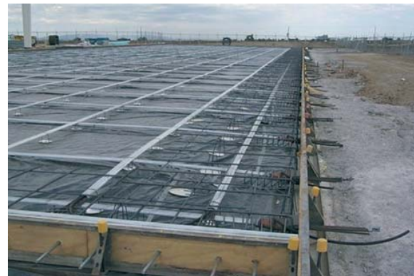
Bild 14: Vorgespannte Industrieböden erfordern gute konstruktive Details.
