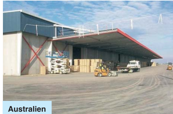
Bild 13: Vorgespannte Industrieböden für Container Terminals und Verteilerzentren
