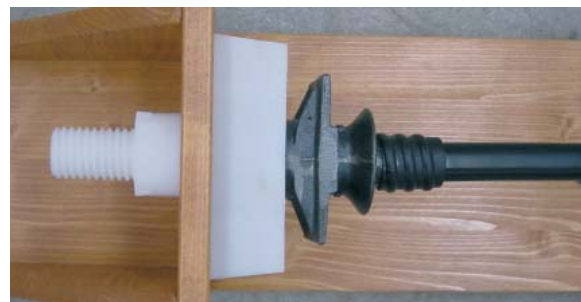
Abbildung 4: Montage der Spannverankerung inkl. Nischenaussparung
