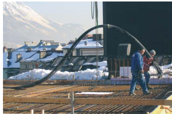
Abbildung 3: Verlegen der Spanntragleisten
