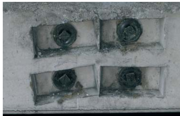
Abbildung 7: Nischen nach Abschluss der Spannarbeiten
