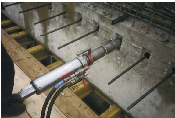
Abbildung 6: Vorspannen der Spannglieder
