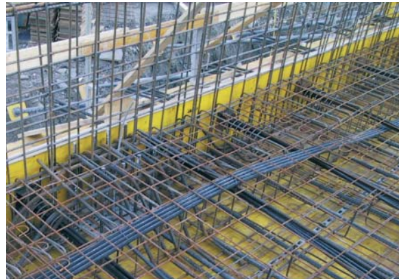
Abbildung 1: Vorgespannte Flachdecke
