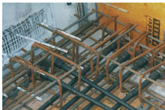
Abbildung 5: In die Bewehrung verlegter Festkopf
