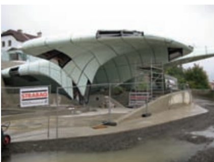
Fast fertiggestellte Dachschale Hungerburg Bergstation
