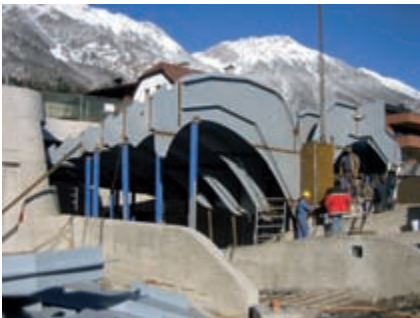
Stahlkonstruktion Hungerburg Bergstation
