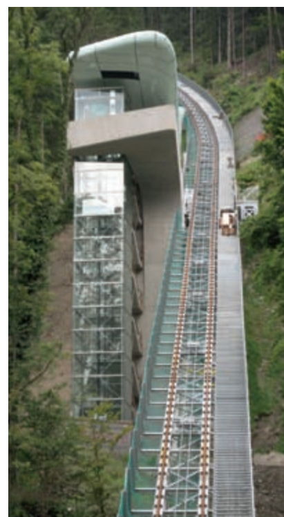
Station Alpenzoo und Steilstrecke
