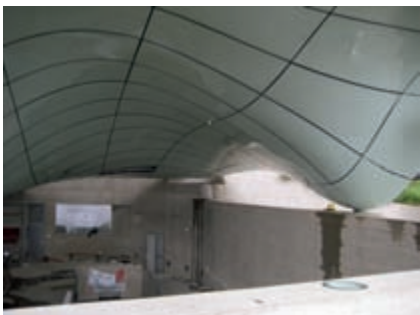
Verglaste Dachschale Hungerburg Bergstation
