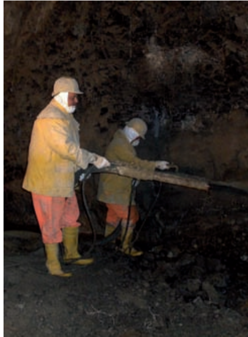
Trockenspritzbeton im Tunnel
