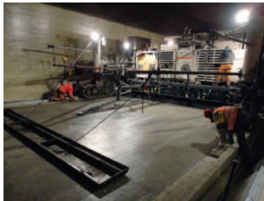
Herstellung Betondecke
