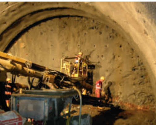
Laden der Sprenglöcher
