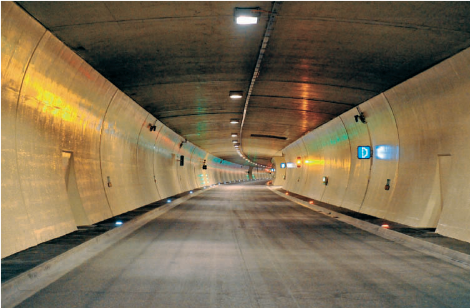
Fertig gestellter Tunnel ohne Markierungen
