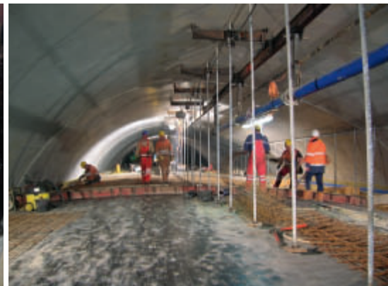
Einbau Trennwand, Zwischendecke
