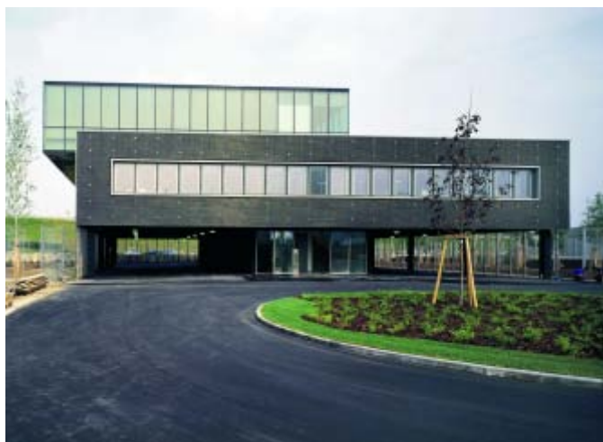
Adolf Krischanitz: Verkehrsmanagementzentrale ASFINAG Foto: © Margherita Spiluttini
