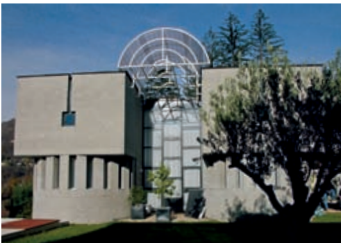
Casa Delorenzi, Origlio, Architekt Mario Botta
