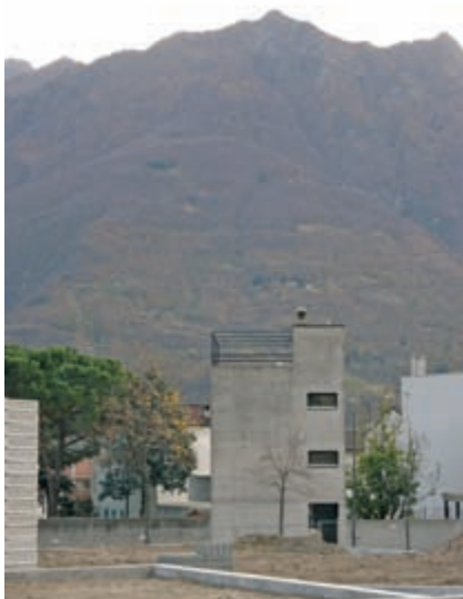
Einfamilienhaus Monte Carasso Architekt Luigi Snozzi
