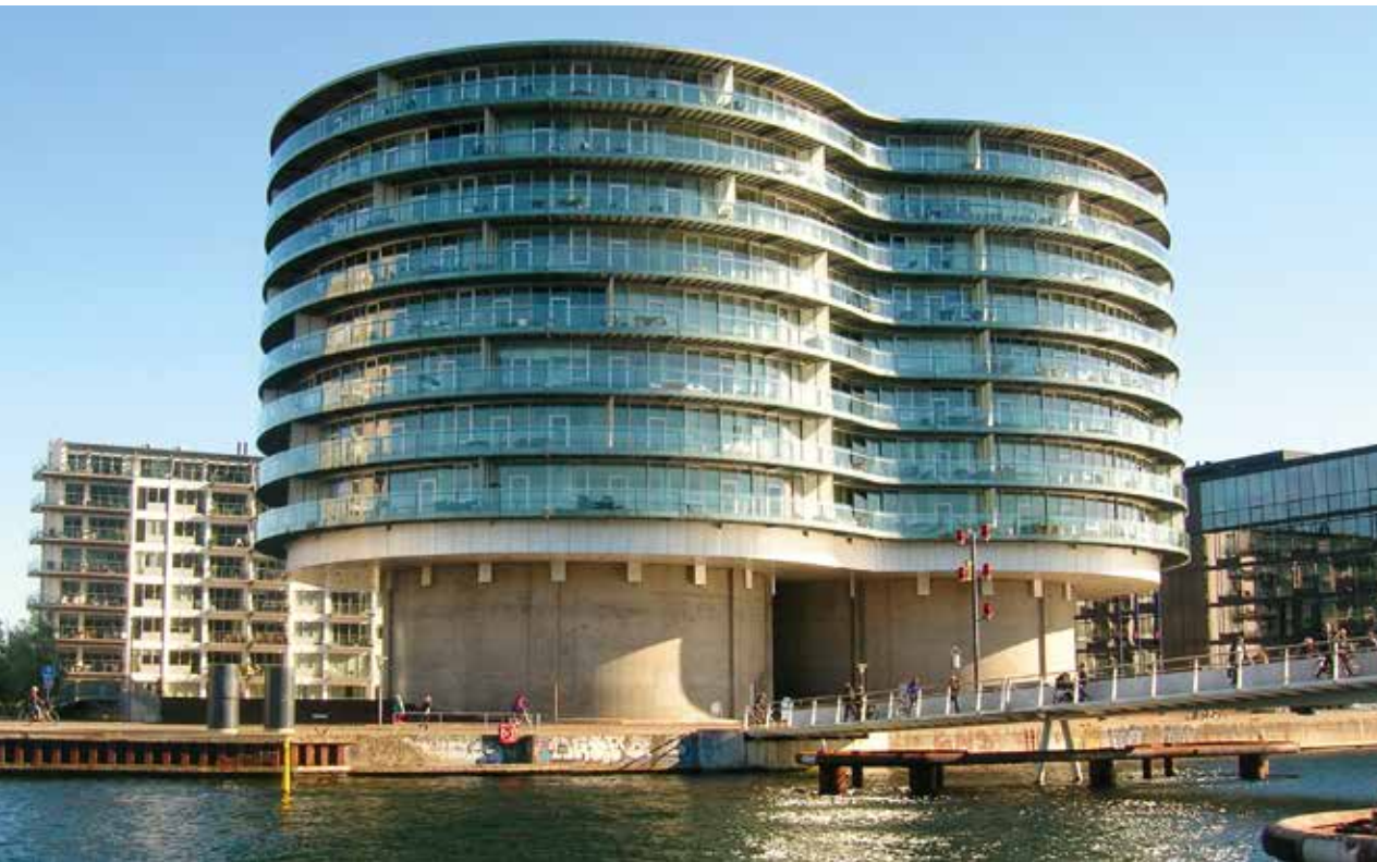
Ehemalige Speicher werden zum Wohnen direkt am Wasser genutzt. © Gary
