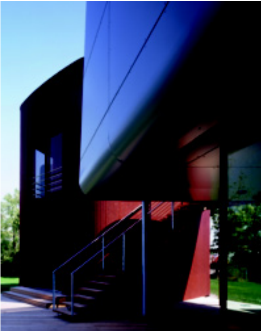
Das Gästehaus im roten Zylinder, davor der Eingang zu Terrasse und Wohnbereich
