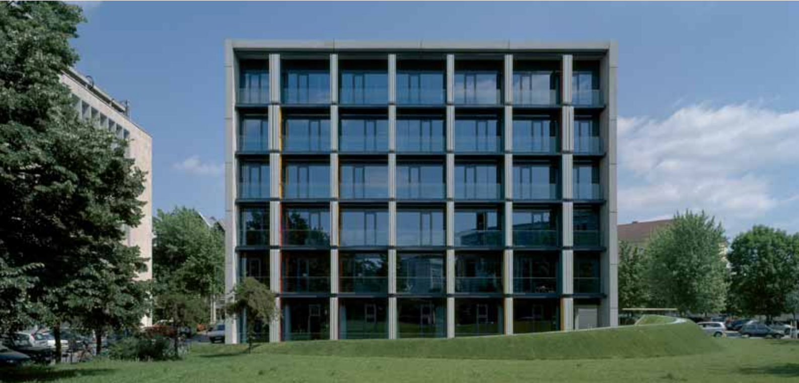
Biokatalyse, TU Graz, Südfassade, Foto: © Paul Ott
