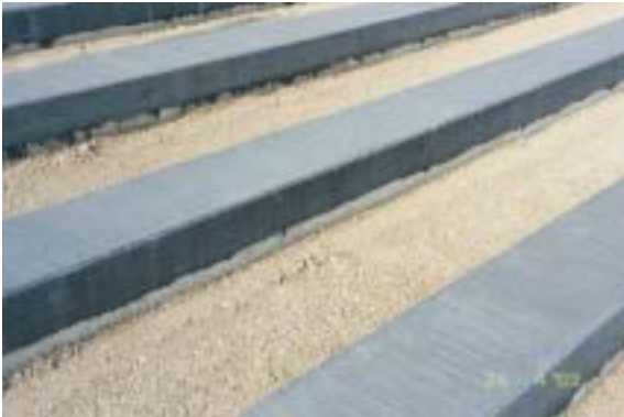
Stützmauern als statische Sicherung des Rutschhanges mit Feinplanum für Pflasterarbeiten.
