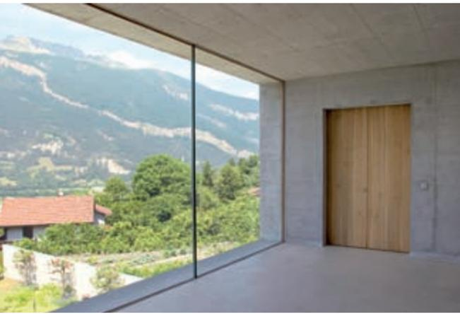
Bei der monolithischen Konstruktion stellt der Isolationsbeton die gewünschte Statik und die geforderten Dämmwerte sicher.
