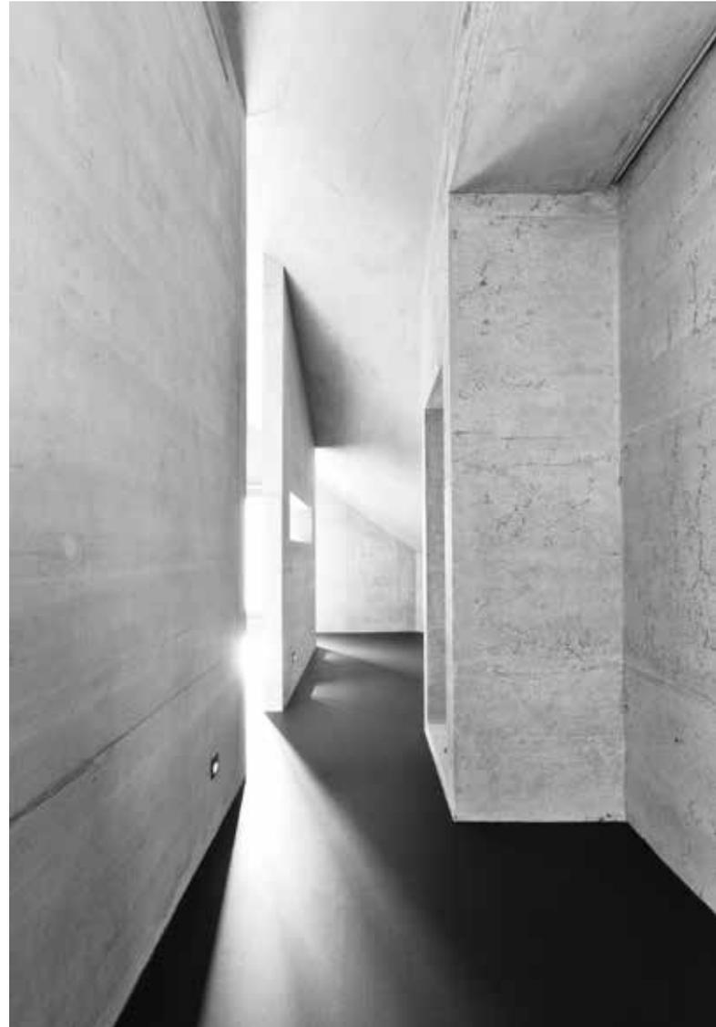
Diese Bauweise erinnert an die Massivität von Burgbauten. Die tiefen Außenwände, die ausgehöhlt werden und so Räume für Treppenhäuser, Zimmer und Nischen schaffen. Die Konstruktion prägt die äußere Form und das Erscheinungsbild des Gebäudes. Durch die polygonale Grundform und das mehrfach geknickte Dach wirkt der Baukörper mit seinen rohen Oberflächen wie ein Findling in der Landschaft.
