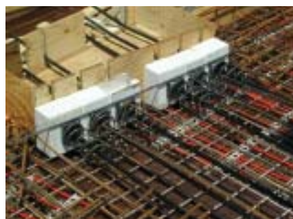
Spannnische – Spannkopf – Spannlitzen
