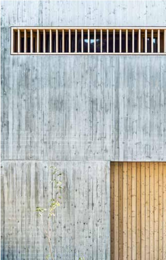
Der mehrfach gefaltete Baukörper reagiert mit einem verzogenen Giebel auf der einen Seite und mit einem Flachdach auf der anderen Seite auf die Umgebung. Das Haus ist zweischalig mit Kerndämmung aus Sichtbeton gebaut und wurde vertikal mit ca. zehn Zentimeter breiten Brettern aus Lärchenholz so geschalt, dass sich die Struktur des Holzes an der Fassade deutlich abbildet.
