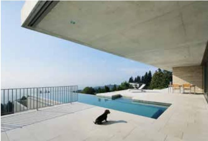
**Der eher grob ausgeführte gestockte Beton steht im klaren Gegensatz zur exakten und glatten Struktur des Sichtbetons in den Wohngeschoßen.**
