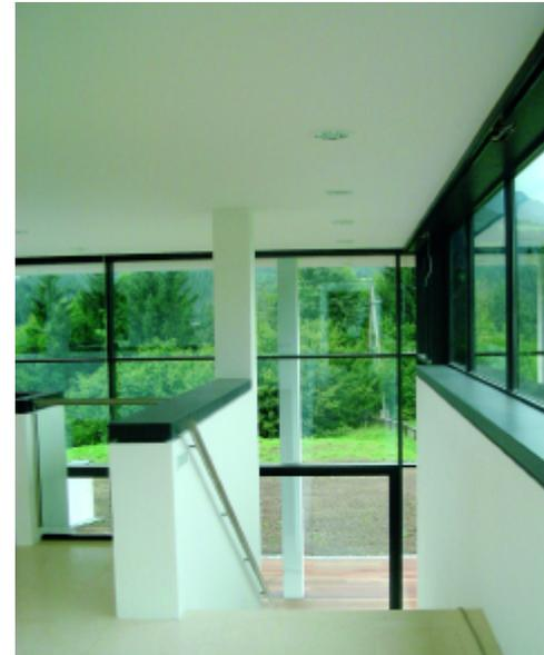
Die gesamte Tragkonstruktion besteht aus Ortbeton, wobei die vertikalen Tragelemente – von den Fassaden abgerückt – im Inneren des Hauses liegen. Damit werden die Fassaden von tragenden Elementen befreit, was zu einer freieren Gestaltung beiträgt.
