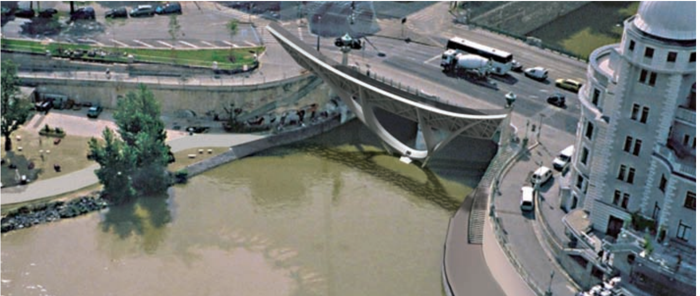
Gesamtansicht – Brücke geöffnet
