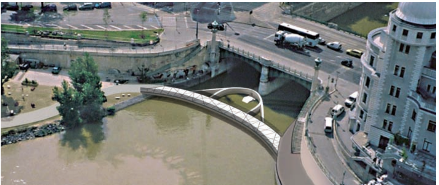
Gesamtansicht – Brücke geschlossen
